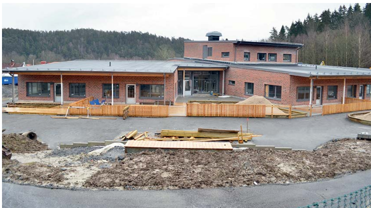
I juni är det slutbesiktning av Bagarevägens förskola i Henån. Vänd och läs mer om de nya moderna lokalerna.
